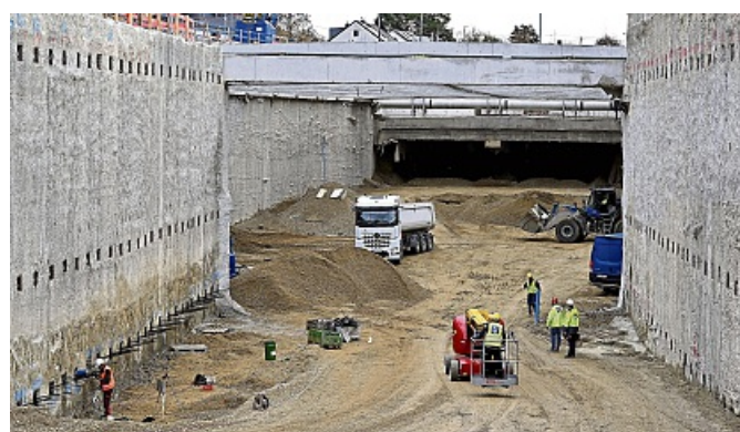
In Kürze erhält die neue U-Bahn-Station eine Betondecke – die Nachbarn dürfte es freuen. ASTRID SCHMIDHUBER (2)
